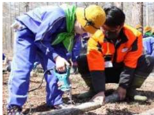
〈電気ドリルで穴をあける〉
